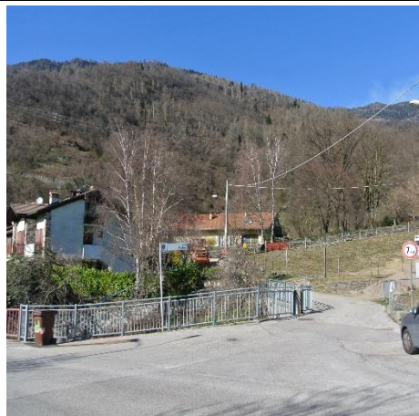
Vista a valle, collegamento con SP11
