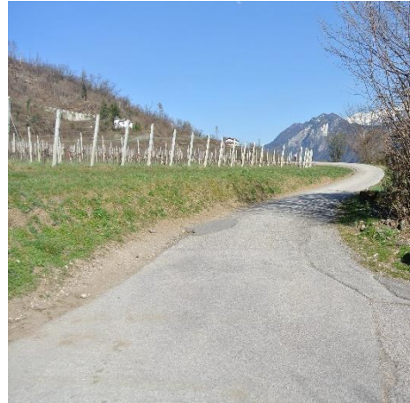
Vista a valle, collegamento con Variante V6
